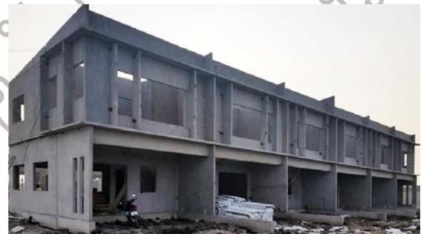
รูปภาพที่ 1 : คือโครงการก่อสร้างแบบขึ้นส่วนคอนกรีตสำเร็จรูป (Pre Cast)
