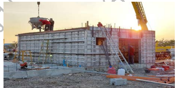
รูปภาพที่ 2 : คือโครงการก่อสร้างแบบวิธีการเทหล่อในที่ (Tunnel Form)
