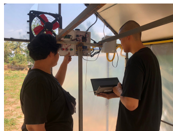
(ก) ติดตั้งกล่องควบคุม
